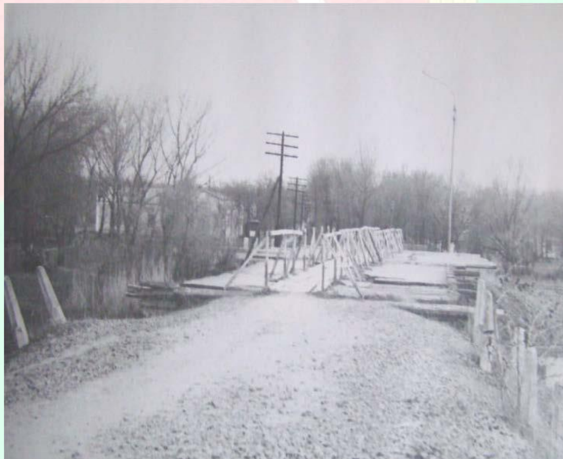
Восстановление старого моста через реку Кагальник
