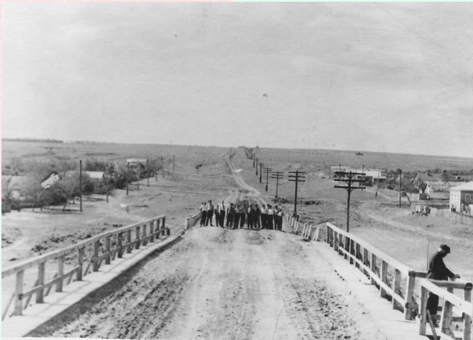
Отремонтированный старый мост, вид на «кузьминовку», фото 1950-х
