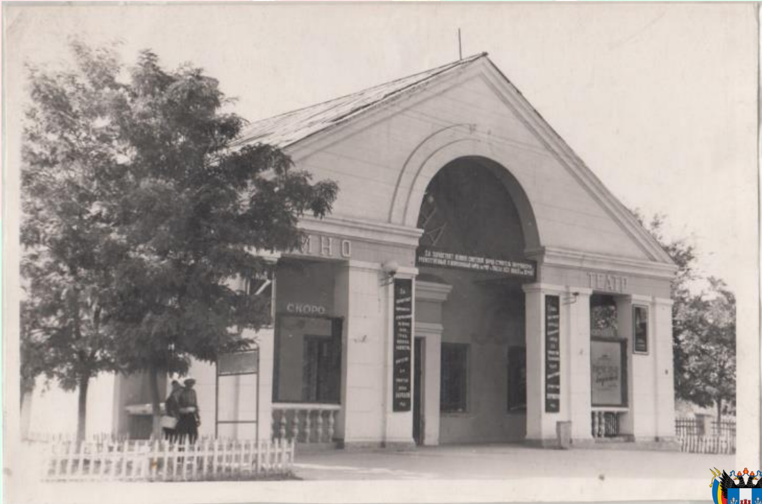
Кинотеатр «Родина», был построен в 1953 году, прекратил работу в 1995 году, разрушен в 2009 году.
